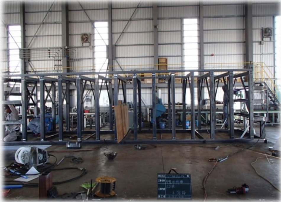
① 補強用SS材 枠組
