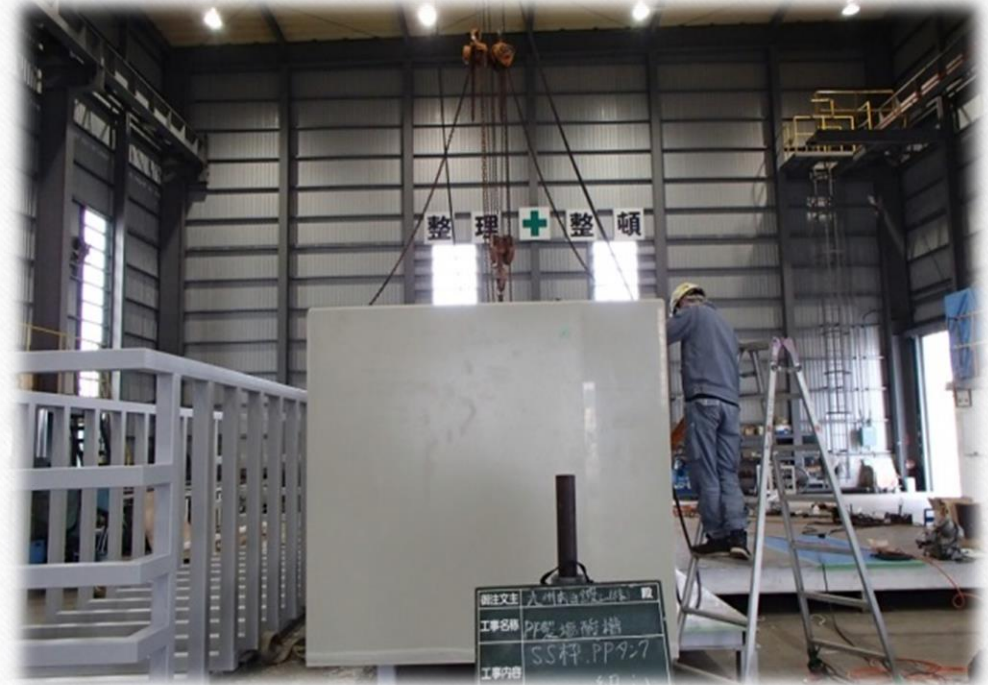
② PP製 酸洗槽組立完了
