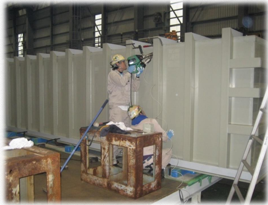
⑤ 補強用SS材被覆(1体化)
